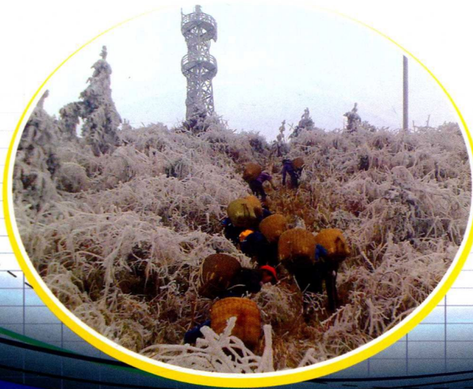
人工运送抢修设备到基站，确保人民群众的通信畅通
