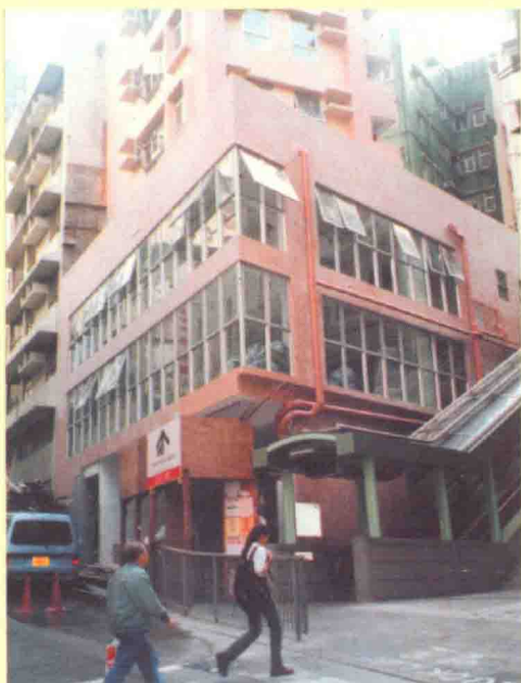
广东建设实业公司与广东国际公司合作发展项目——上环伊利近街启基阁（一九九六年十二月十三日）
