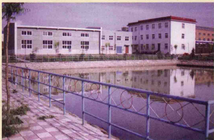
▲ 中水回用工程是铁道部和长春市示范性环境保护项目，每日可处理废水6000吨、回用水3000吨，年节约价值上百万。
