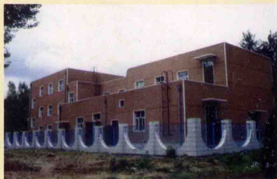
▲ 工厂总变电所。
