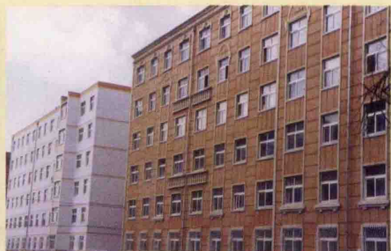
▲ 4.38万平方米员工住宅当年施工、当年竣工、当年交付使用。
