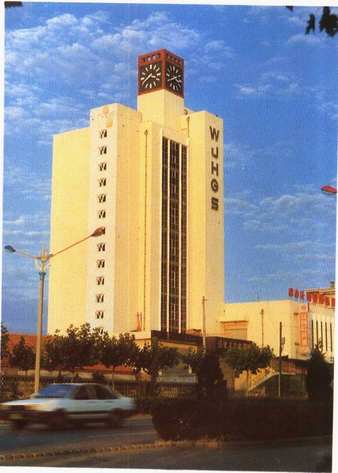
县五金交电化工总公司营业楼
