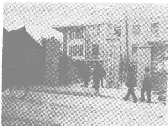
县人民医院门诊部
