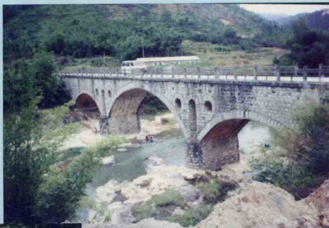
石门坑石拱大桥 ▶
