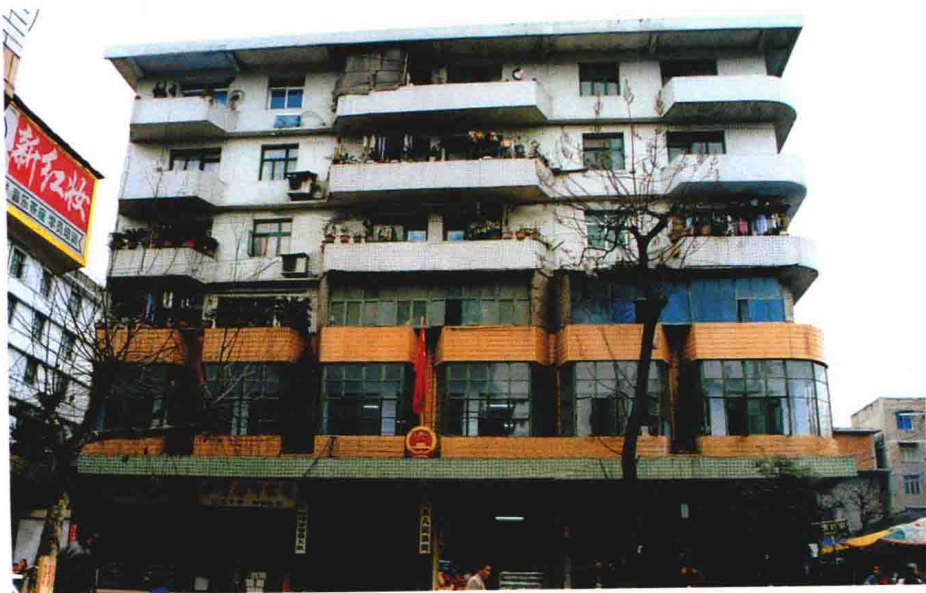
◀ 开江县人民法院办公住宅综合楼。（1989年9月建成）
