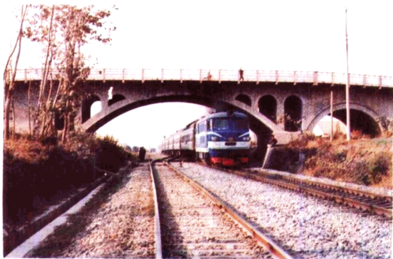
胡集公铁立交桥
