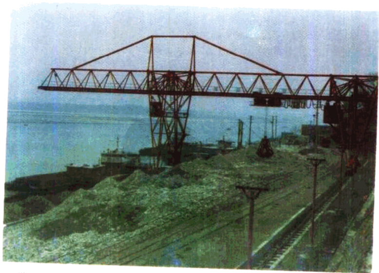
荆河港口轻型装卸桥
