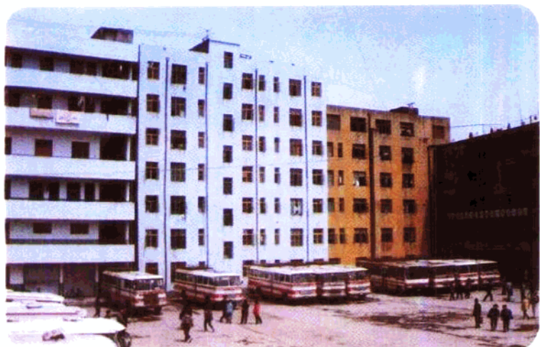
市汽运公司客车停车场
