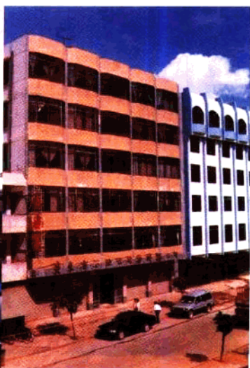
▲徐闻县石油总公司办公大楼
