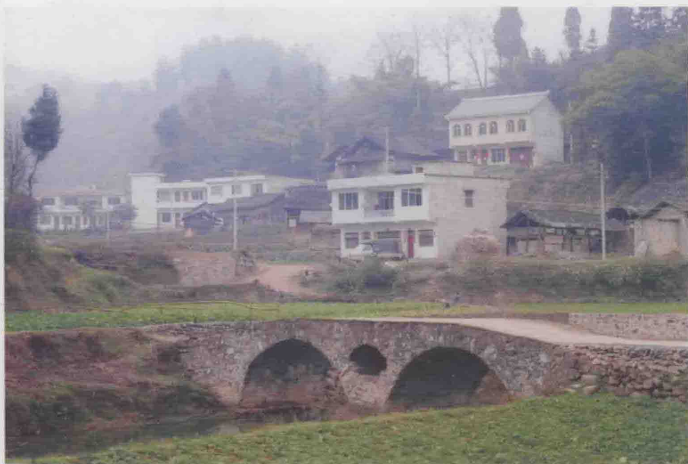
苟江镇大水坝局部
