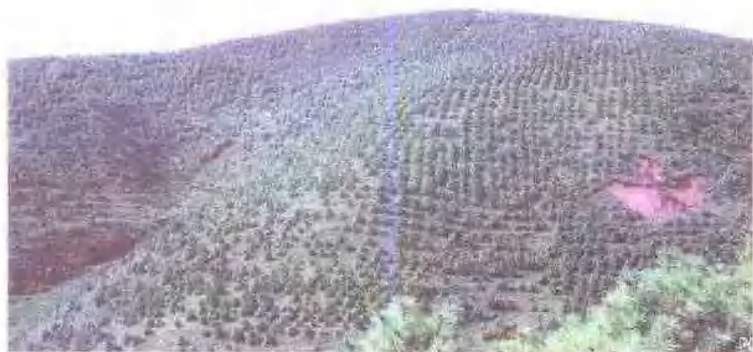
东川长江防护林工程
