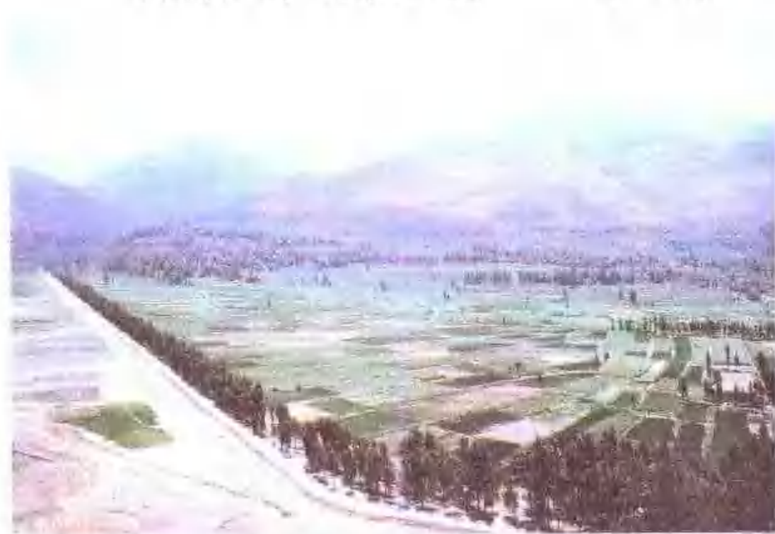
泥石流治理工程
