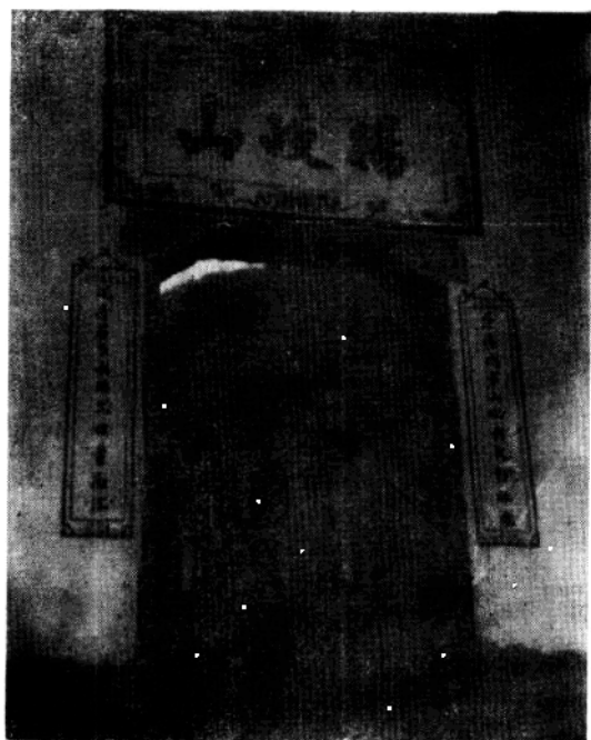
楊岐山普通寺山門
