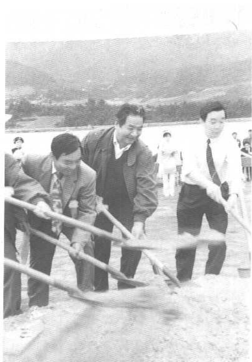
10. 图为中央、省、州的领导同志给兰坪铅锌矿前期工程奠基培土的情景。
