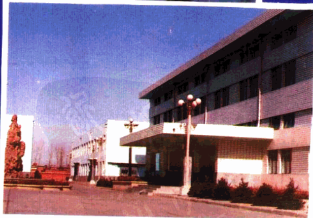
输液车间、水针车间
