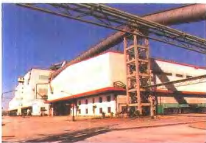
100吨大电炉厂房外景
