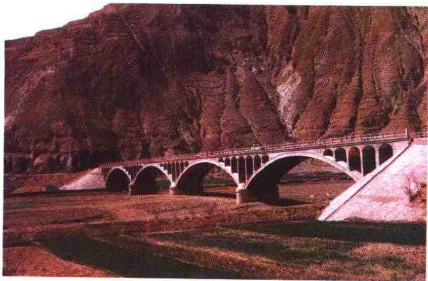
新建的礼县茨坝大桥
