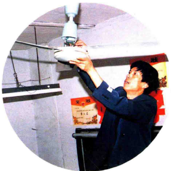
考点工作人员逐一检 查维修考室降温设备。
