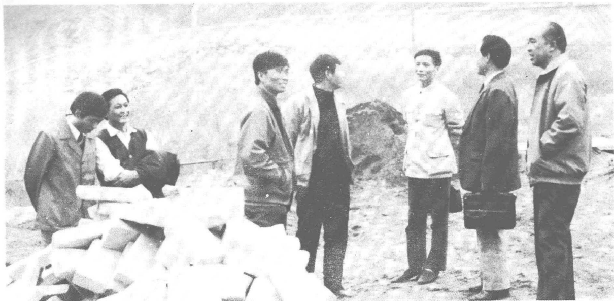
地委领导在涪陵城三环路察看房屋修建现场。
