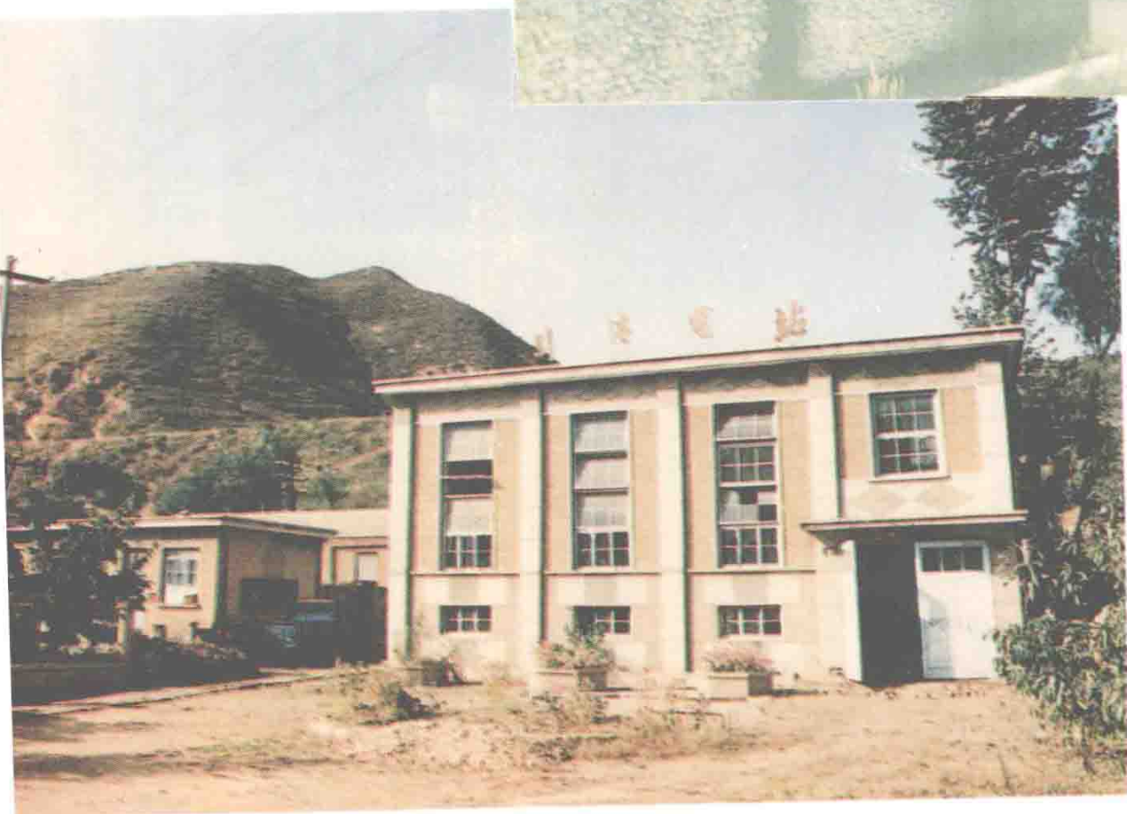
密云县第一座小水电站——引清电站
