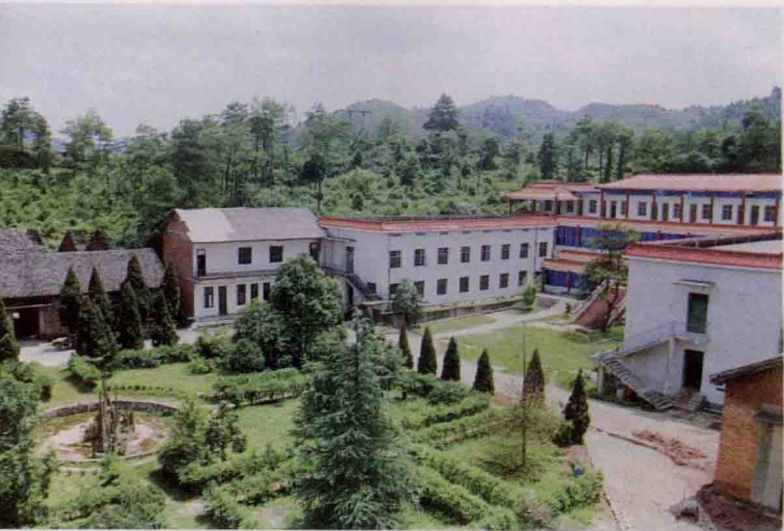
△德兴制药厂远景
