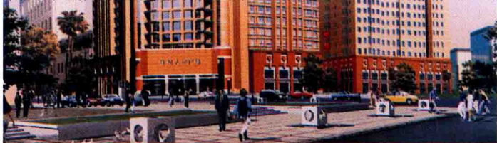
正在建设中的吉林省人才市场大厦世纪人才广场。
