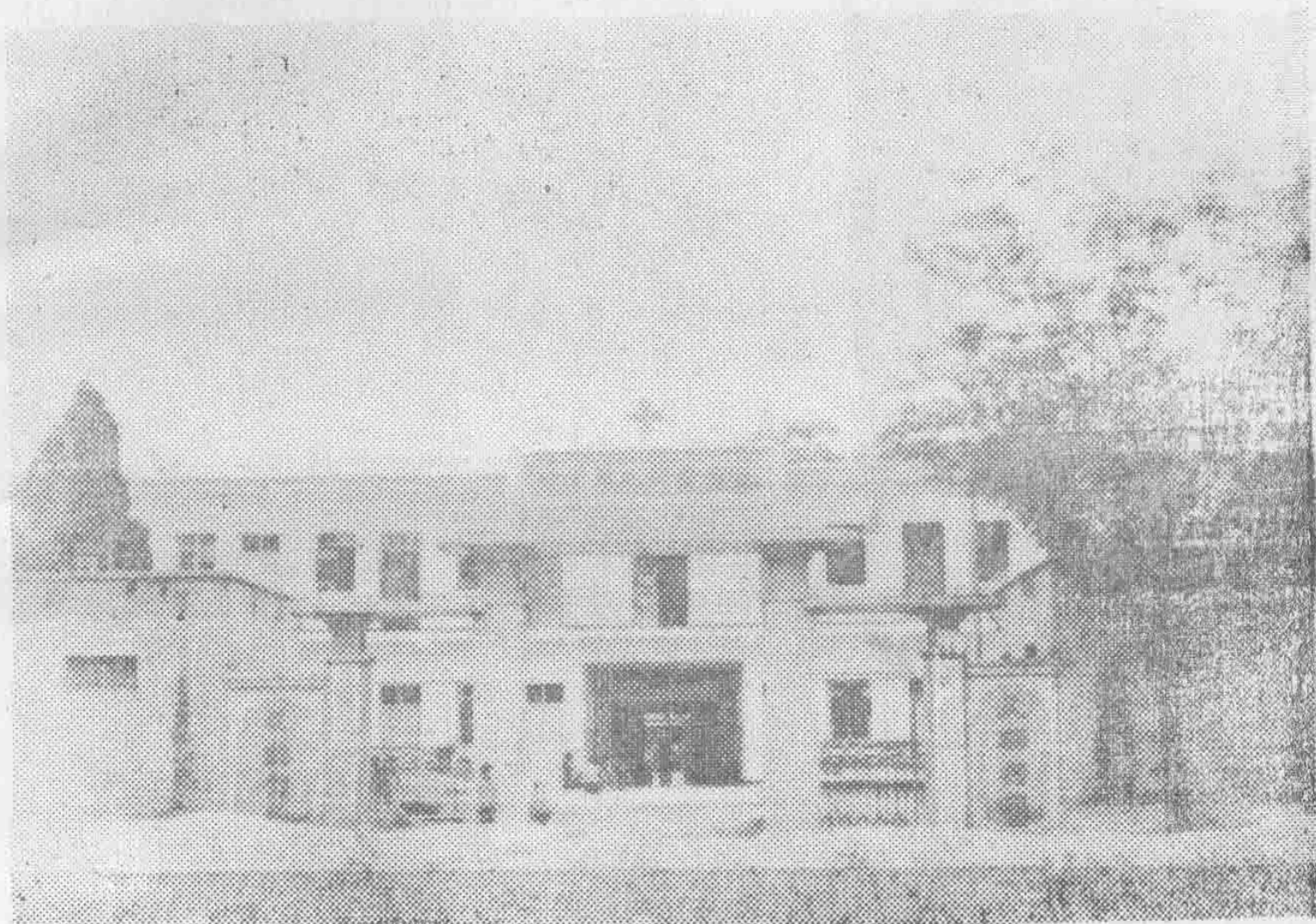
石桥镇卫生院
