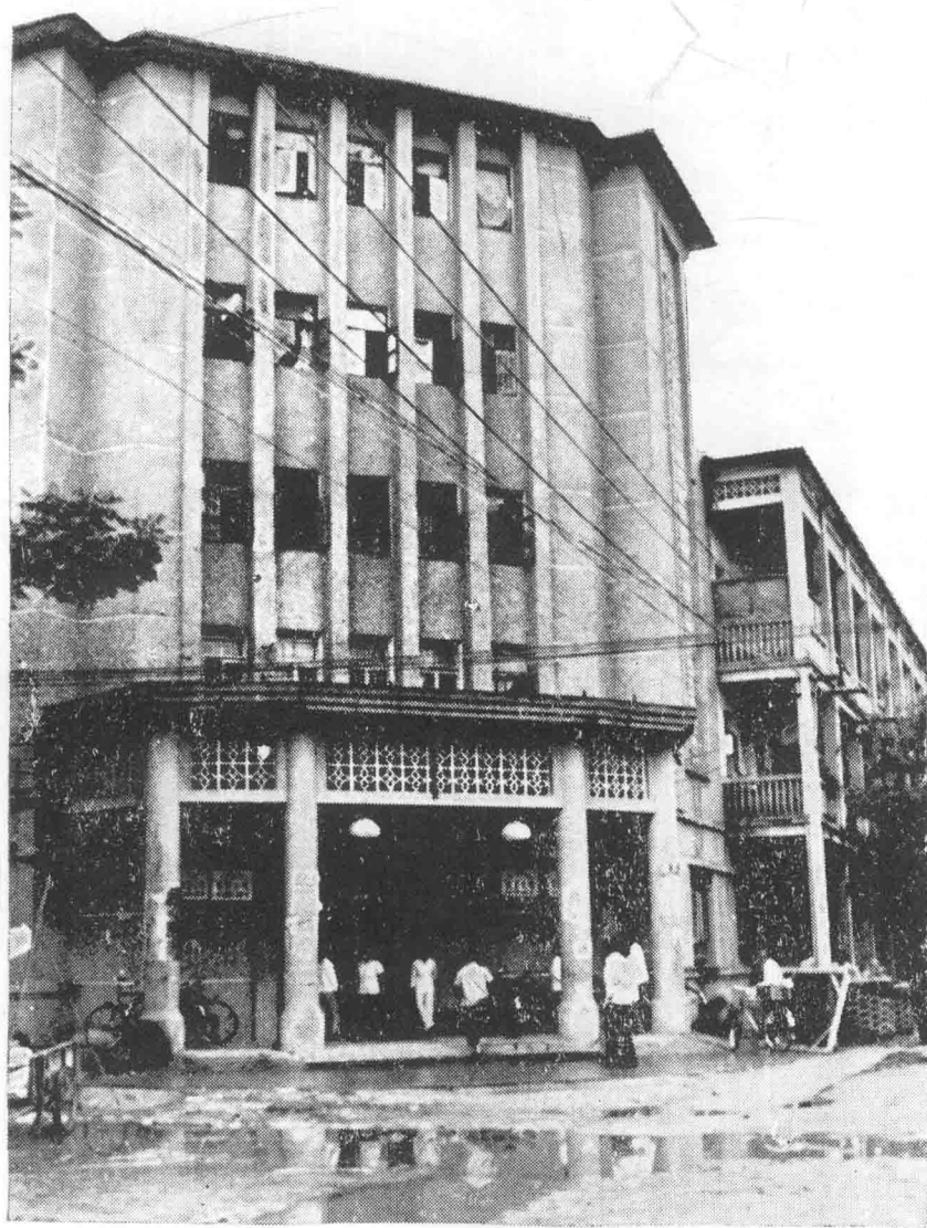
大埔县二轻工业公司办公大楼正面五层结构，位于东风路34号， 建于1974年，1982年竣工。
