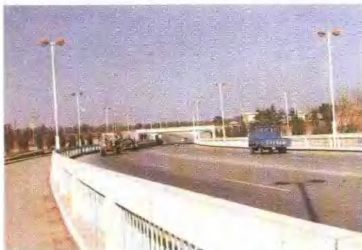
辛庄铁路、公路立交桥
