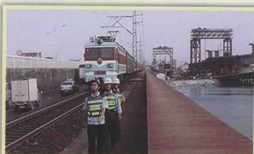
高集海堤 是厦门岛与大陆连结的第一条通道，海堤全长2212米，1953年动工，1955年10月建成，在高崎一头建观堤亭，亭上有朱德委员长亲笔题写的“移山填海”四个大字。
