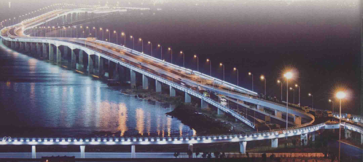
集美大桥 于2006年12月开工建设，2008年7月1日建成通车，大桥全长8.438公里，宽36米，双向8车道。
