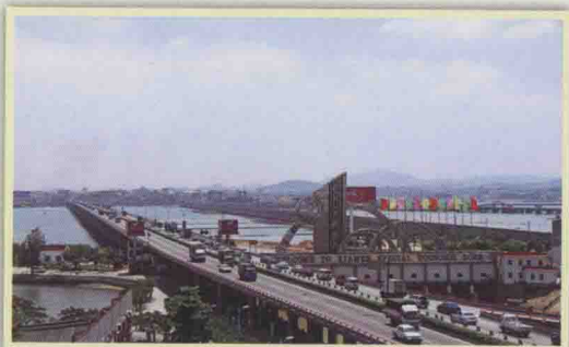
厦门大桥 是我国第一座跨越海峡的公路大桥，建于1987年10月1日，1991年5月试通车。桥梁总长度为6599米，桥面宽23.5米。
