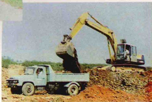
▽正在改造中的溪婺公路 路建设工地
