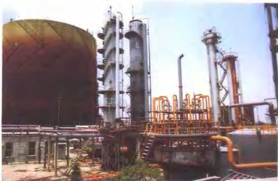
民用煤气净化工程竣工
