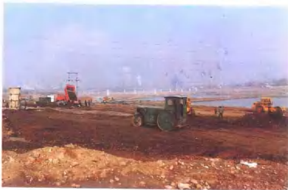
第三炼钢厂工程平整土地
