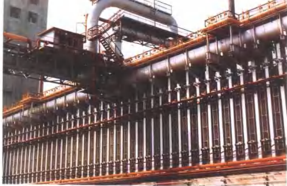
七号焦炉在建设
