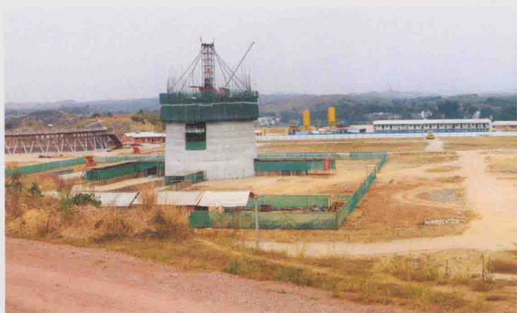
■ 施工中的兴达电厂
