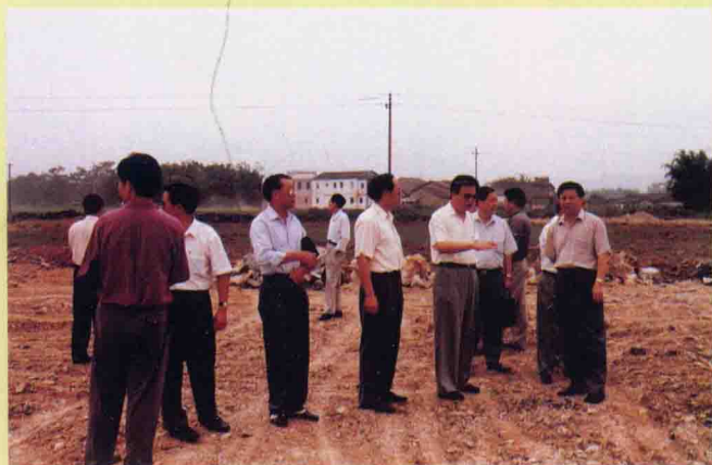
▲市、县领导在公路建设工地上办公
