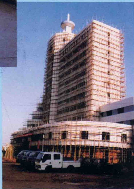
建设在新县城的梅县邮电大楼
