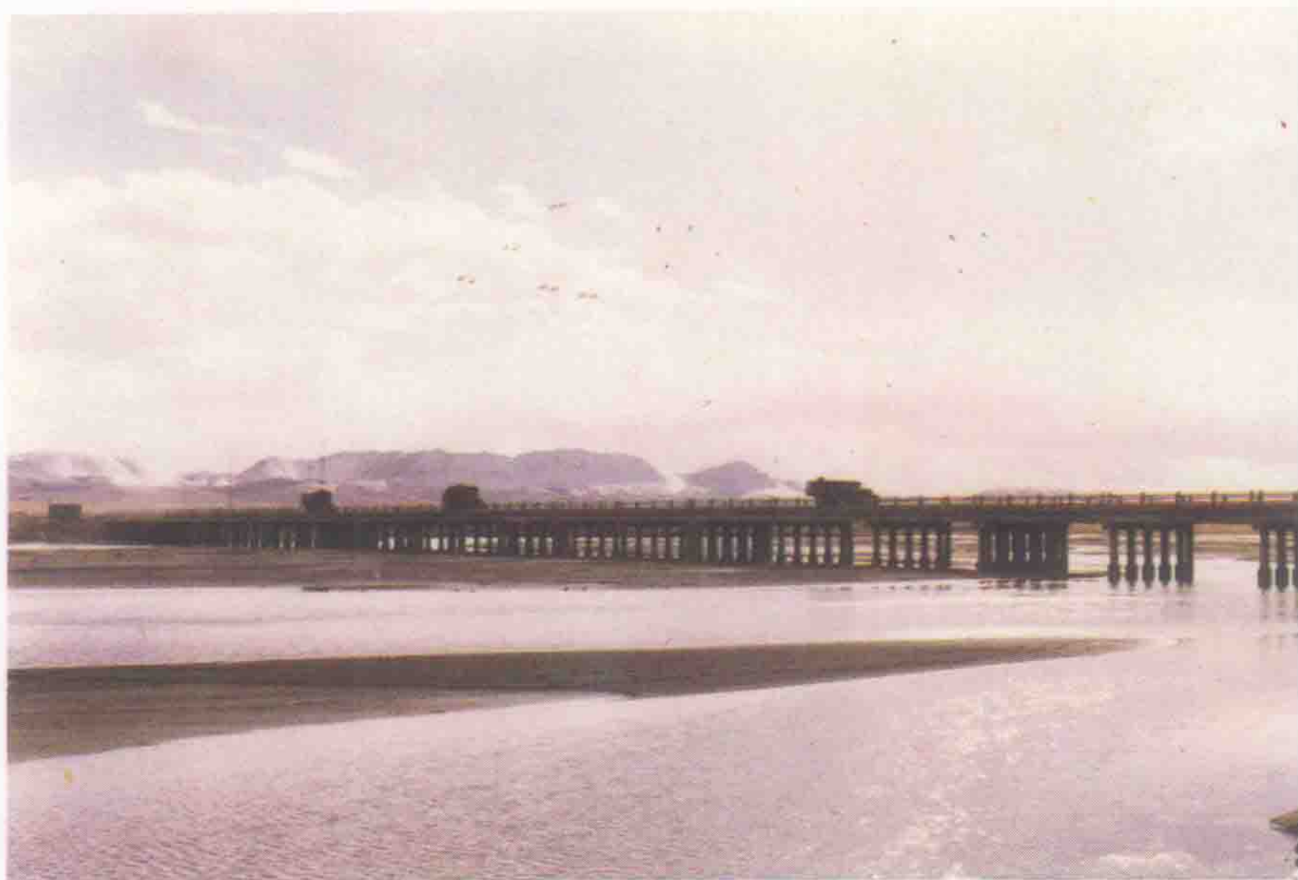
长江源头第一桥(沱沱河桥)
