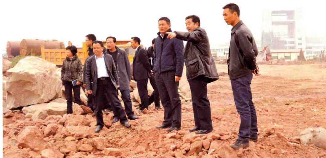
2012年2月21日，罗勇副区长（右三）视察农业园区平基现场
