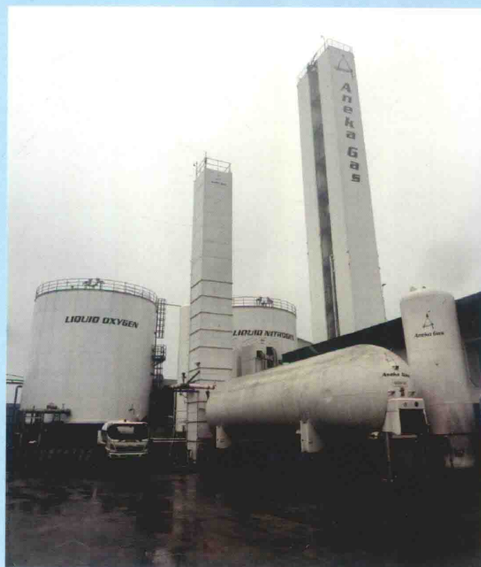
5000m 3 /h空分设备整体交货的分馏塔系统
