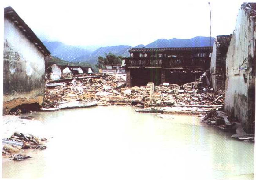
▲ 大田镇茶山坑水库副坝崩溃,洪水冲毁了南庄村
