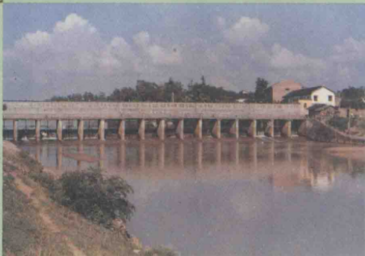
望江桥闸灌溉工程
