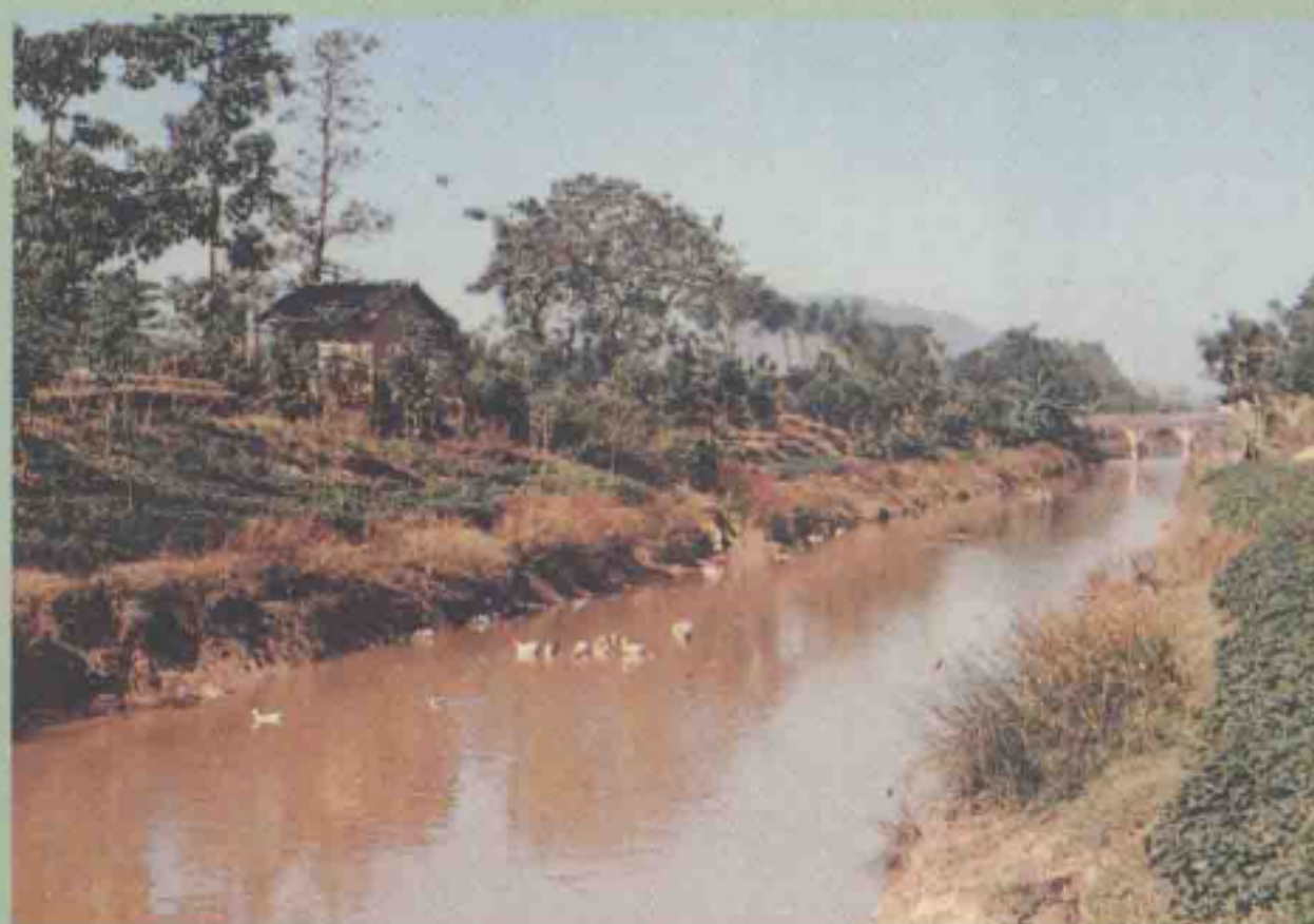
宁江西岸排灌工程刁坊段
