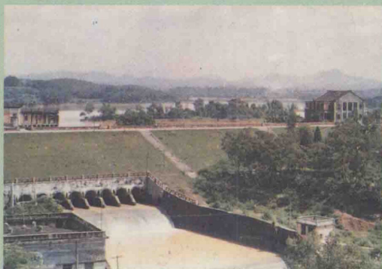
合水水库洩洪闸
