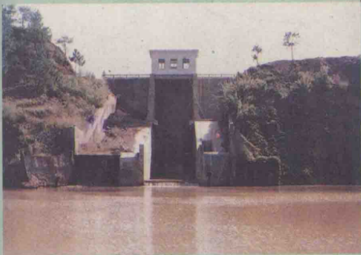
石壁水库冲淤闸
