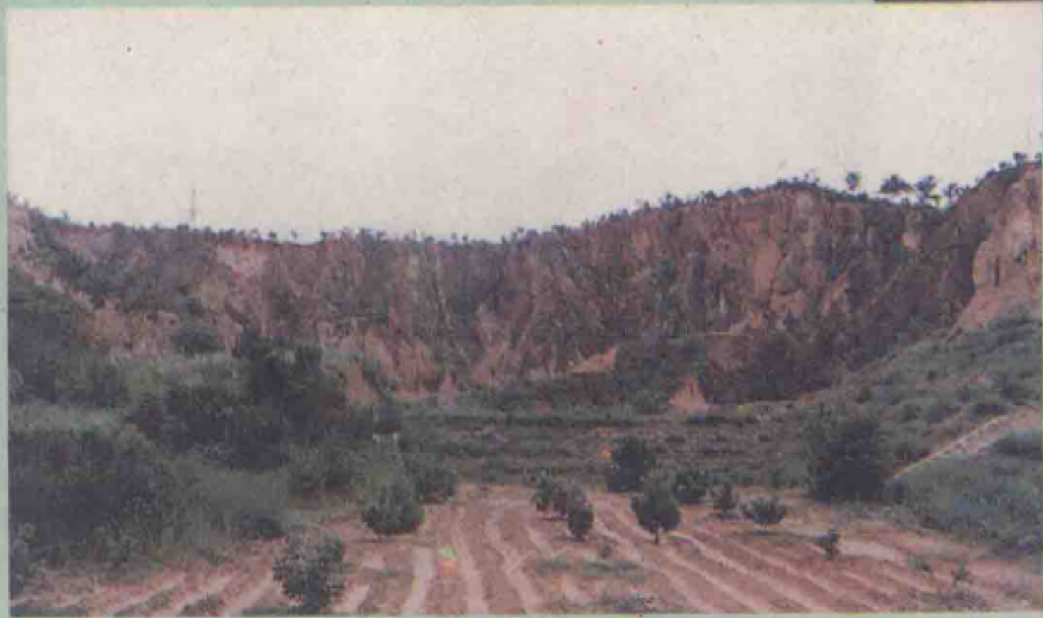
石马镇大窝里水土保持工程
