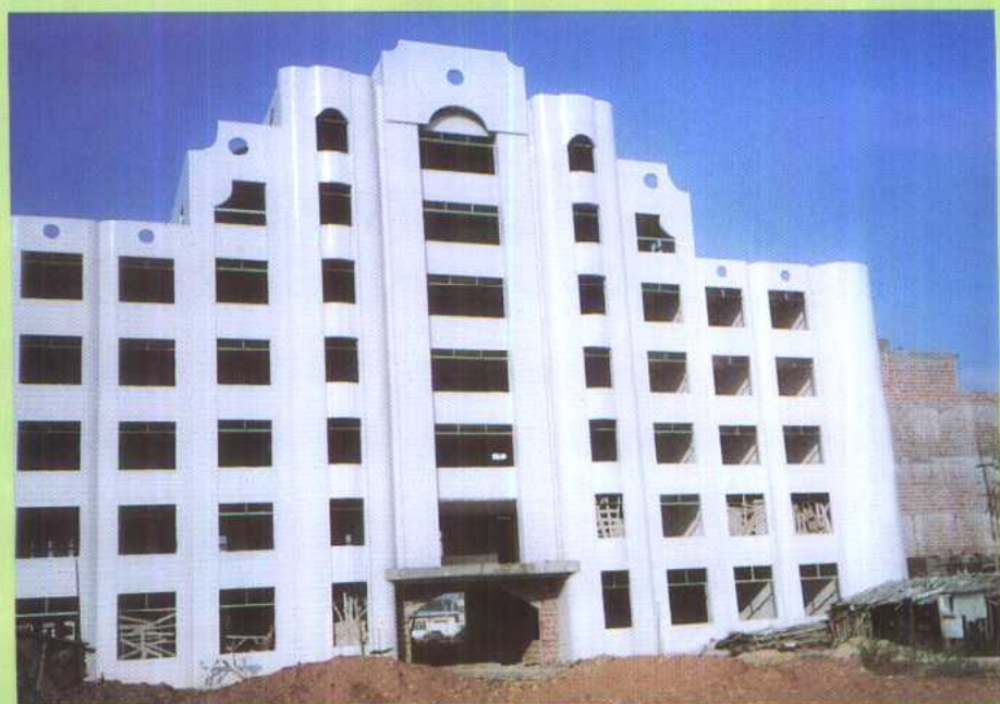
在建设中的县妇幼保健院大楼
