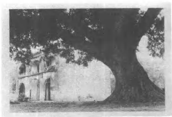
遂溪樂民文明書院舊址
