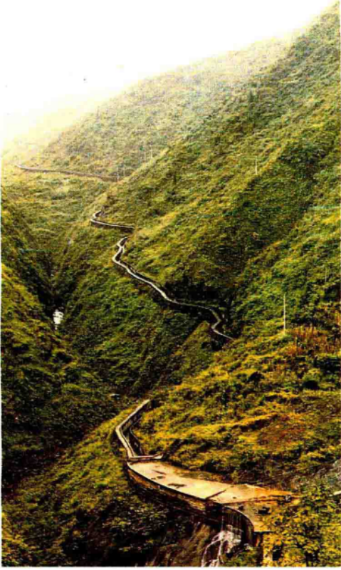
酉阳县胜利水库发电、灌溉渠道。
