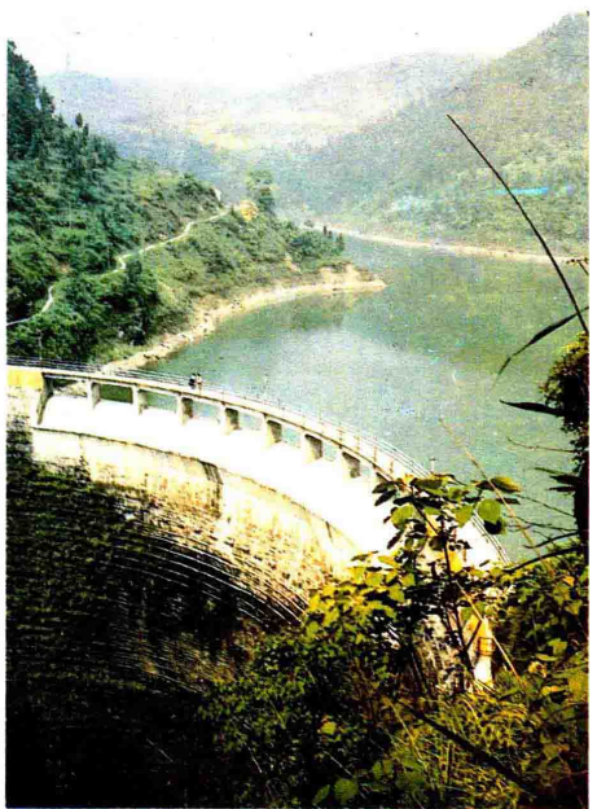
垫江县红旗水库大坝一角。
