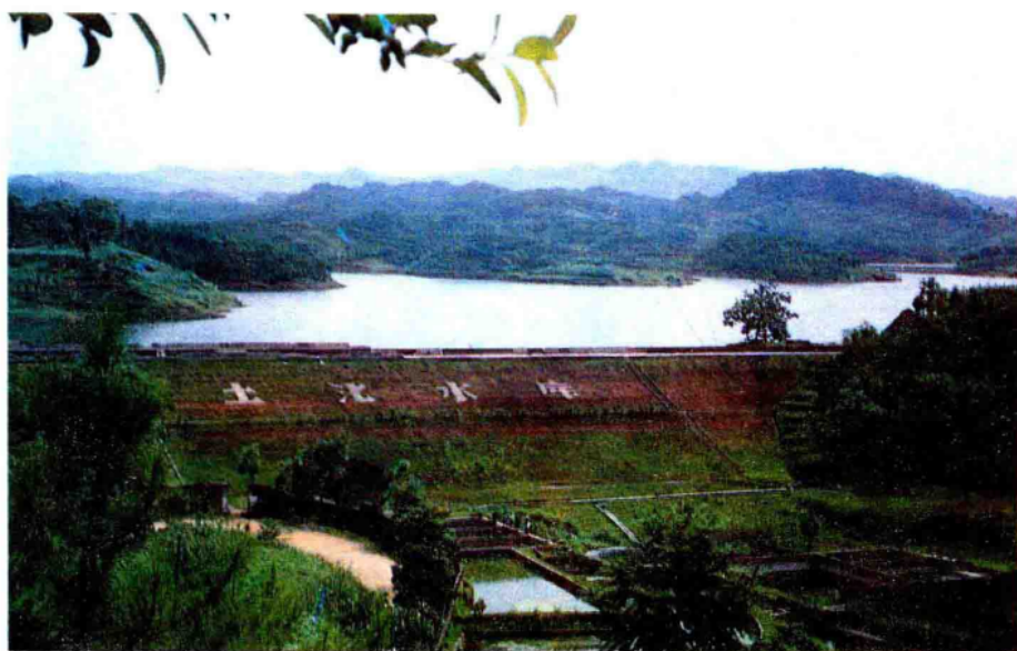
南川县土溪水库。
