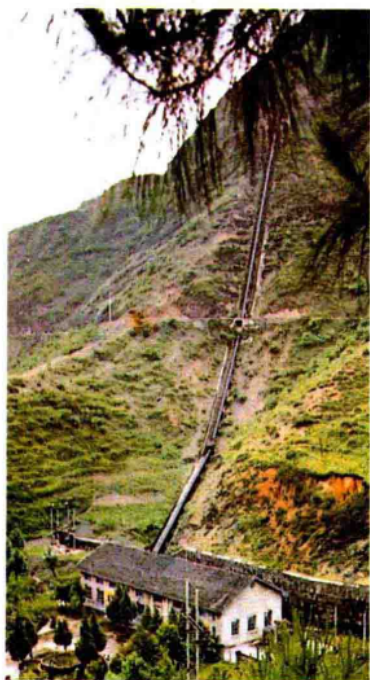
涪陵地区土坎发电厂一级站。
