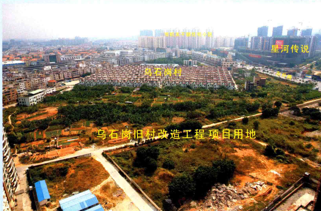
乌石岗旧村改造工程现状
