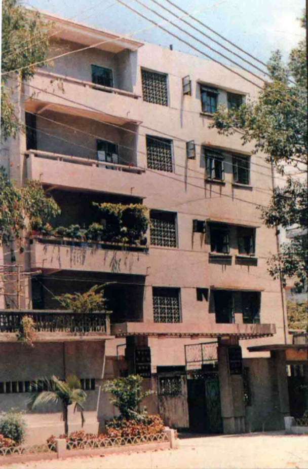
△梅县市财政局 大楼外貌
