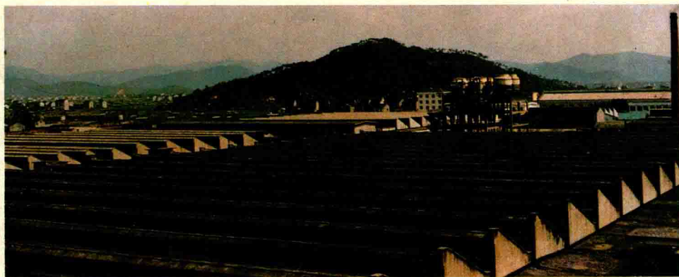
慈溪第二棉纺织厂系本县最大国营工业生产企业，图为该厂一角。
