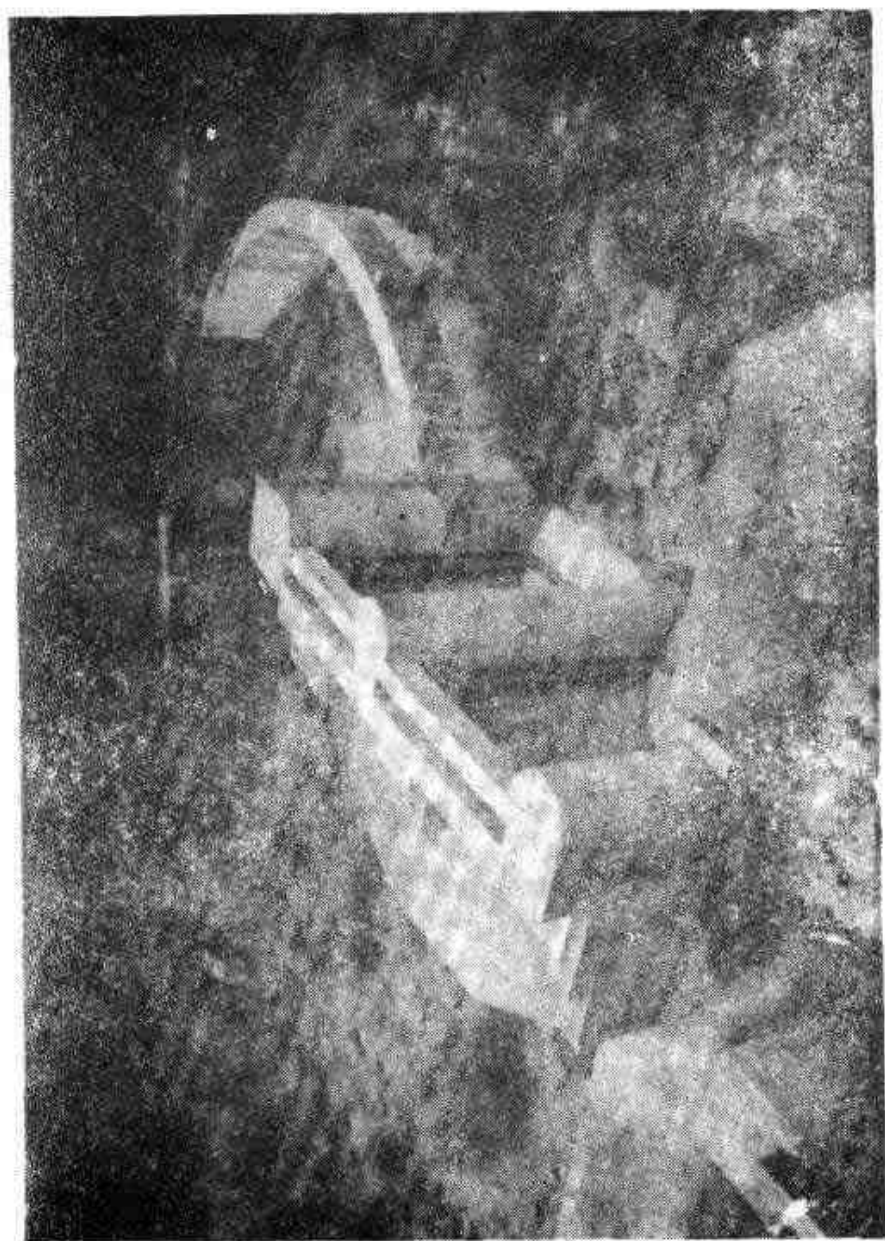
将溪小(一)型水库溢洪坝
