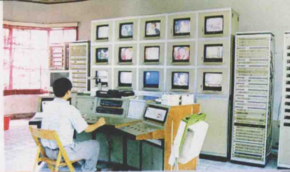
▷德兴市文化广播事业快速发展，实现了乡乡镇镇通有线电视。图为工作人员正在机房调频。
