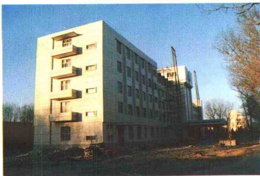
新建中的门诊楼
