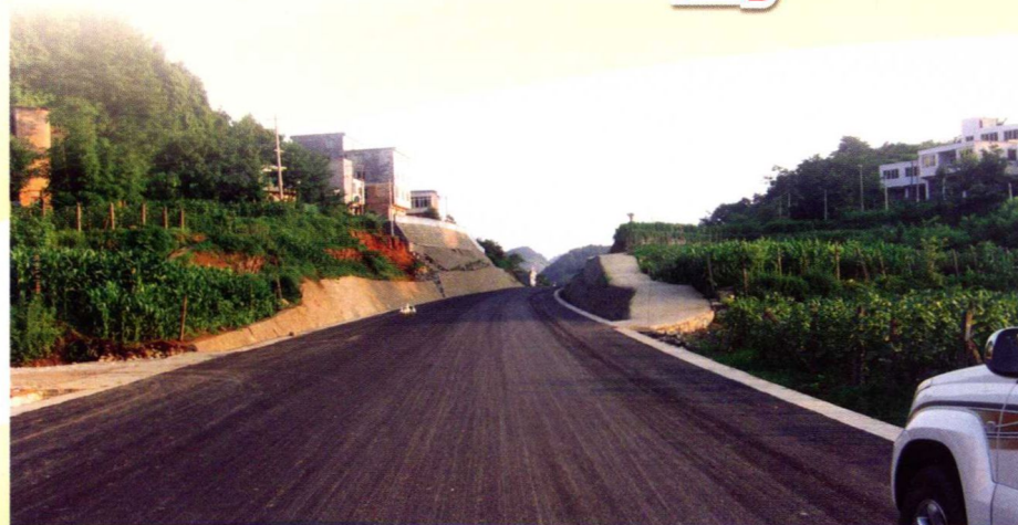
遵义忠深工业大道二级路路基路面一标
