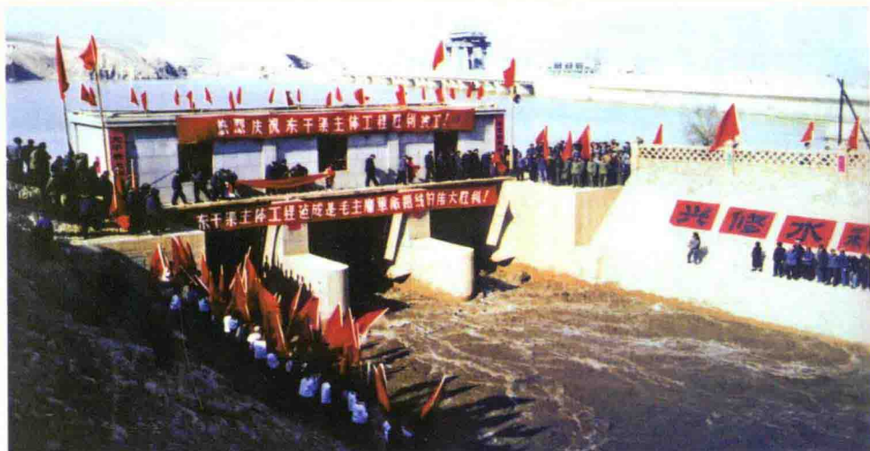
1975年11月5日，东干渠主体竣工
