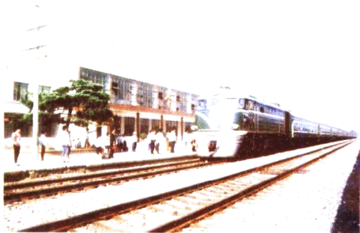
枣阳火车站于一九六五年九月建成并正式投入运营,图为改造后的站貌。
