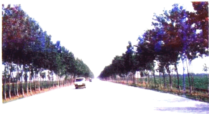
一九九三年五月改建竣工后的省道寺沙线水泥路——枣阳至寺庄段。
