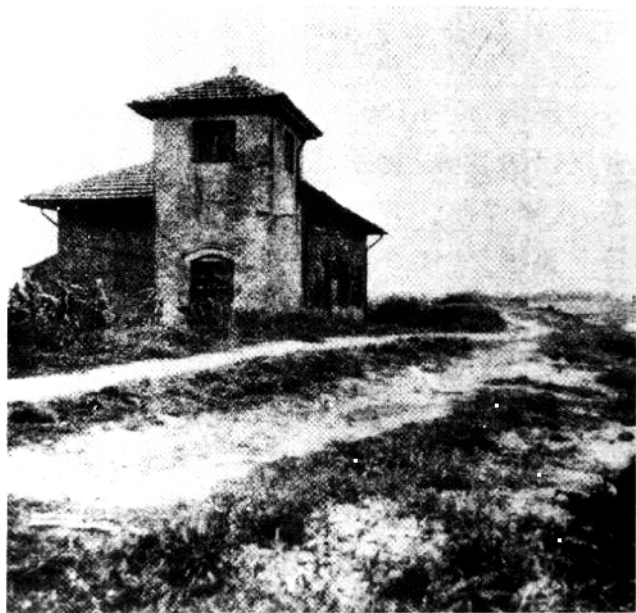
宝山石塘北隅通日本的 电信水线房
