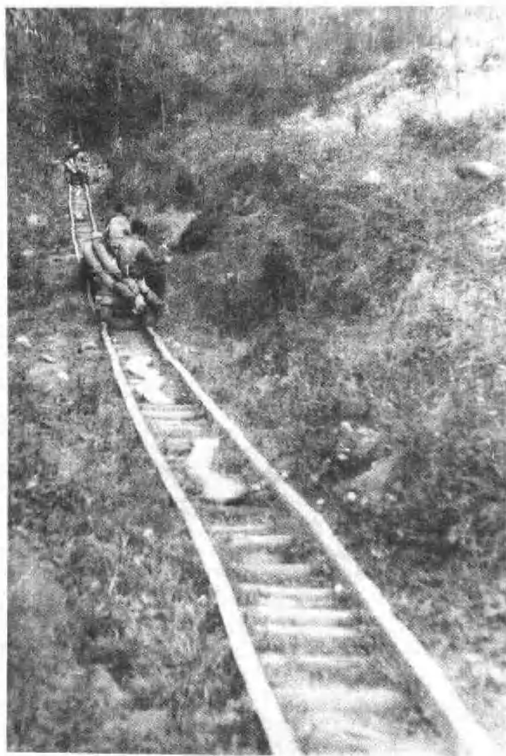
“九一四”工地笋棚至横岩木轨平车运材。(李崇高 摄)
