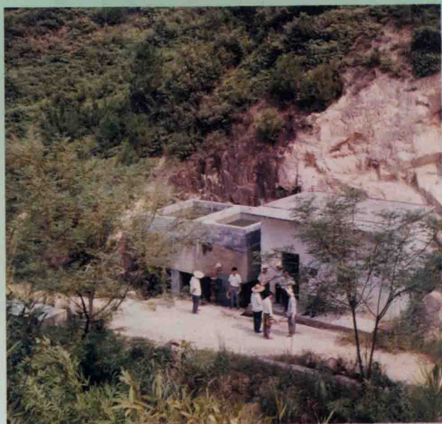
丰良镇供水工程过滤池
