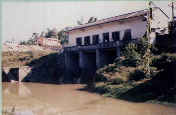
隍九十九曲电排站
