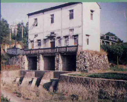
(青园头电排站)
