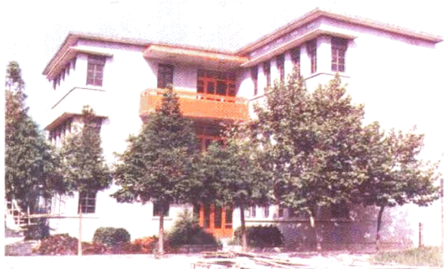
贵阳中学林华实验楼
