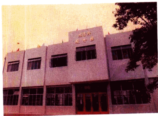
骆驼团桥林杏琴教学楼
